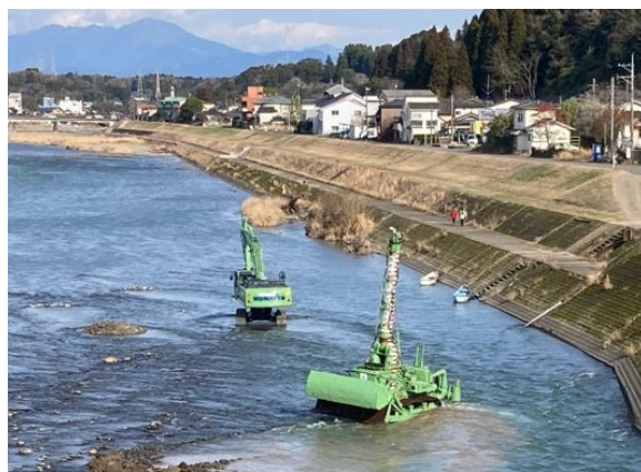
水陸両用ブルドーザ 水陸両用バックホウの施工状況
