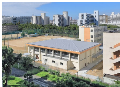
南港北中学校増築その他工事
