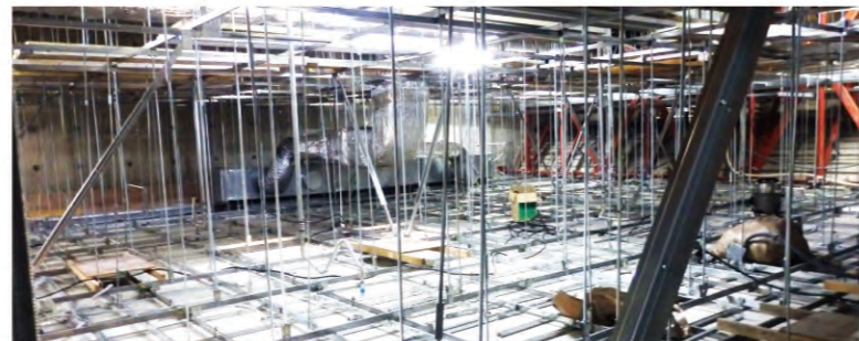
愛知県内「市民病院」(協会員施工) 改修: 天井高さ 6.55m、天井面積265㎡
