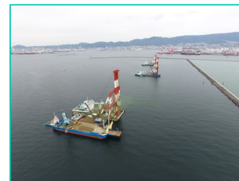
神戸港航路付帯施設地盤改良工事
