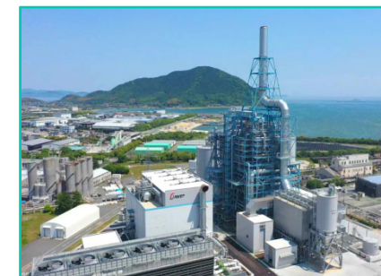
防府バイオマス発電所工事 （保温・耐火工事）
