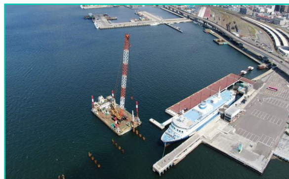
函館港若松地区岸壁改良工事
