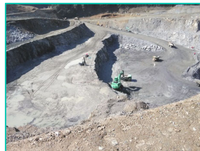
小石原川ダム工事 （爆砕工事）
