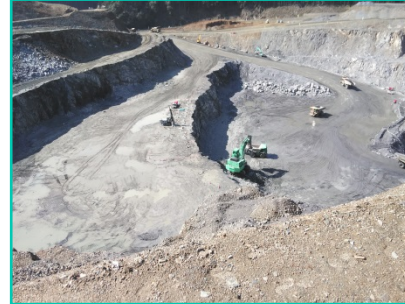
小石原川ダム工事 （爆砕工事）
