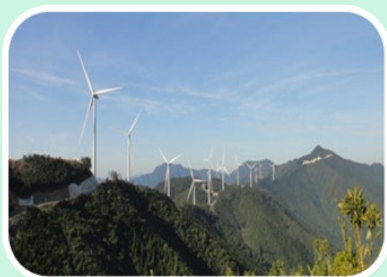
再生可能エネルギー関連工事
