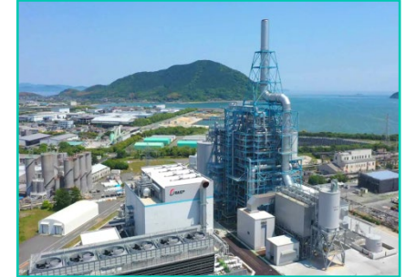
防府バイオマス発電所工事 （保温・耐火工事）
