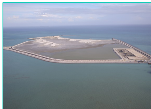
中城湾港土砂処分場護岸築造工事
