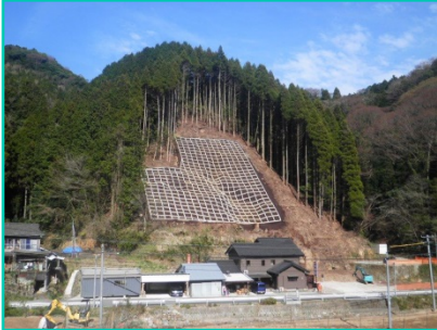
鶴地区治山工事 （法面保護工事）
