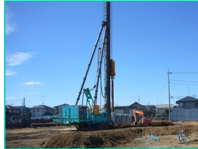
東松山土壌改良工事 （地盤改良工事）
