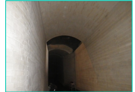
コークス炉煙道改修工事 （耐火工事）
