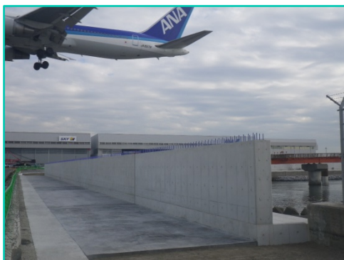
東京国際空港 A 滑走路南側護岸改修等工事
