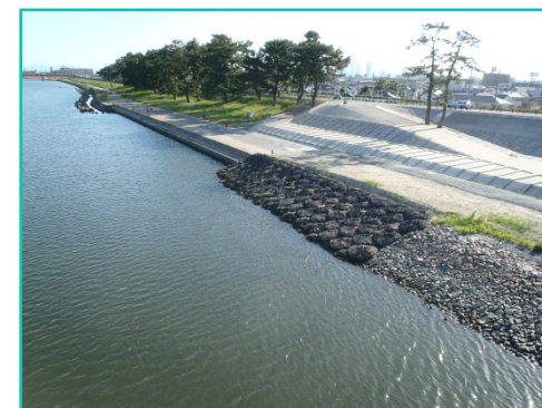
庄内川下之一色しゅんせつ工事
