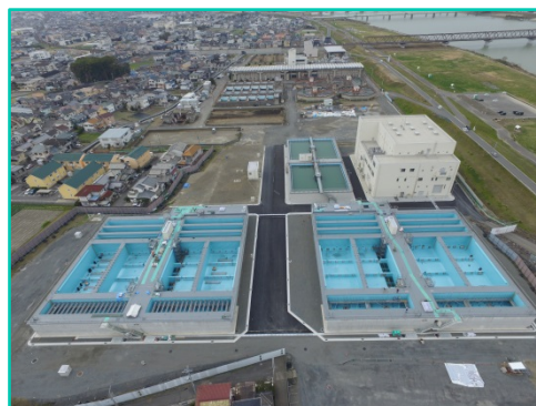
加納浄水場凝集沈殿池築造工事
