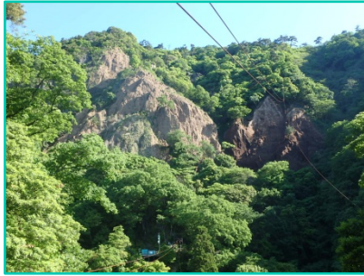
芋川谷山腹工事 （法面保護工事）
