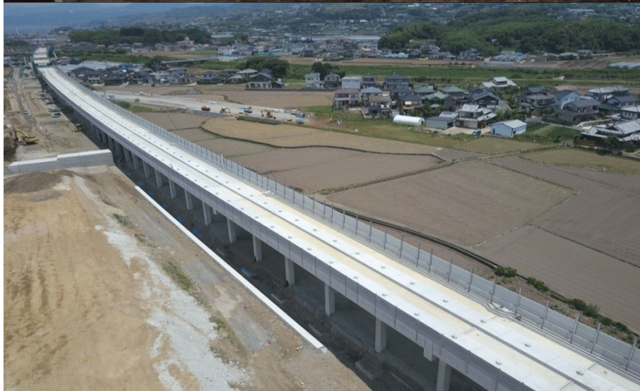
九州新幹線(西九州)竹松高架橋他工事 (独立行政法人鉄道建設・運輸施設整備施設支援機構)
