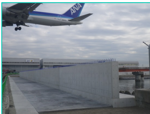
東京国際空港 A滑走路南側護岸改修等工事
