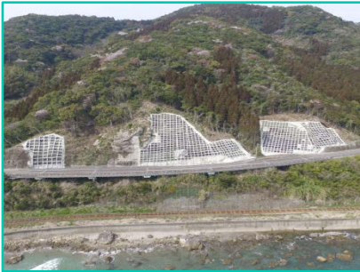
宮崎県内道路防災工事 （法面保護工事）
