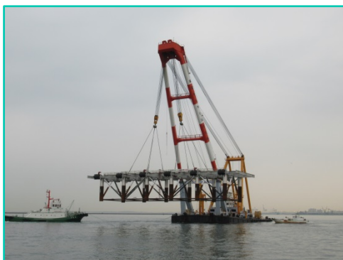
博多港(中央ふ頭地区)岸壁改良工事
