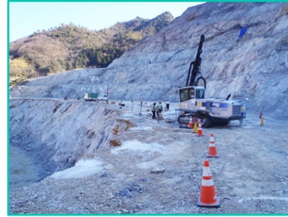
大分川ダム建設工事 （爆砕工事）
