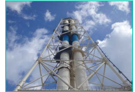
火力発電所煙突内部ライニング工事 （耐火工事）
