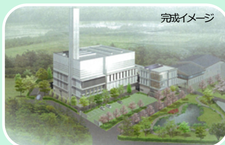
須賀川地域新ごみ処理場
