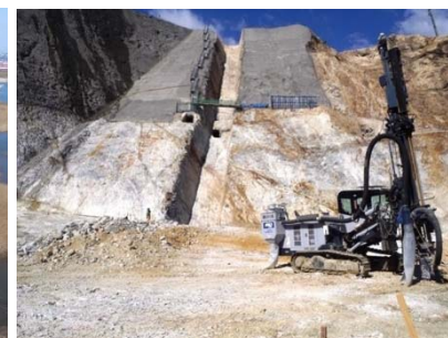
大分川ダム建設工事 (爆砕工事)
