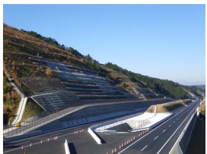
第二東名高速道路牧平工事 (法面保護工事)
