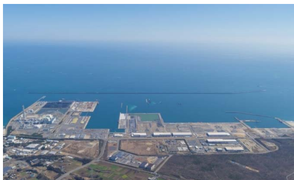
茨城港常陸那珂港区中央ふ頭地区 廃棄物埋立護岸築造工事
