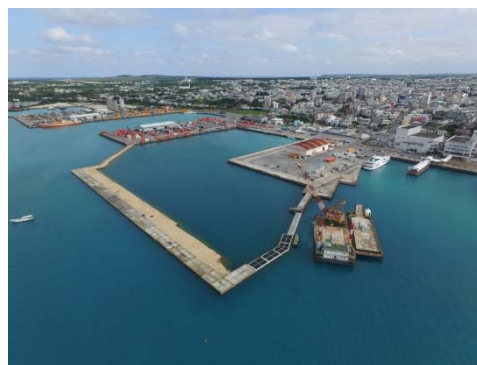
沖縄県平良港岸壁築造工事
