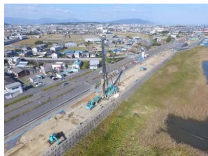
揖斐川地蔵下流川表高潮堤防 補強工事(地盤改良工事)
