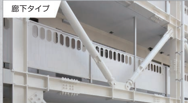
天井の補強と杭工事が必要
